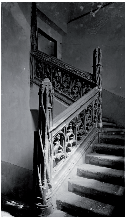
▪ Fig.1. Vista de la escalera del Hospital de la Latina en su ubicación original. J. A. GAYA NUÑO, La arquitectura española en sus monumentos desaparecidos , Madrid, 1961, p. 241.
