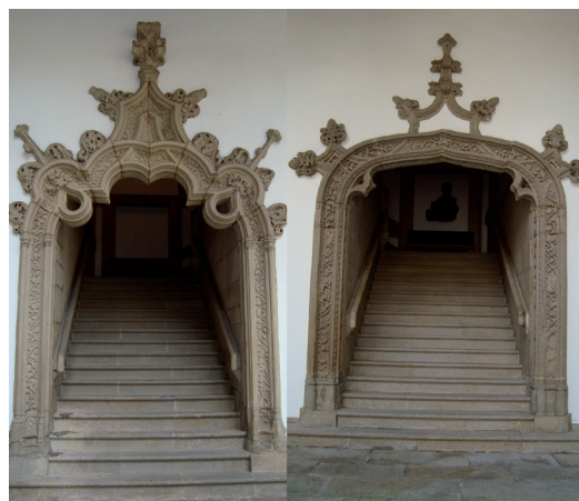
▪ Fig.2. Embocaduras de las escaleras abiertas a los patios anteriores del Real Hospital de Santiago de Compostela, La Coruña. Fotografías del autor.
