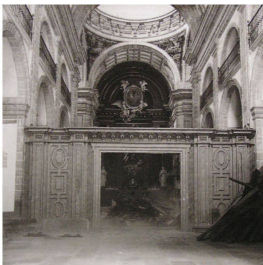
▪ Fig. 11. El desmantelamiento del coro de Samos, julio de 1967. Fondo Fotográfico del Monasterio de Samos.
