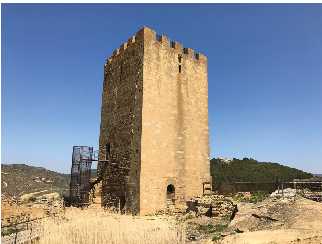
▪ Fig. 10. Torre fortaleza del castillo tras la restauración de los arquitectos Lorente y Chueca, Uncastillo, estado actual. Fotografía de la autora.
