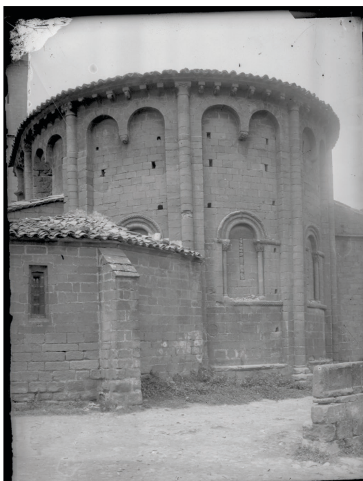
▪ Fig. 6. Iglesia de San Martín, Uncastillo, detalle del ábside antes de la restauración. Fuente: Fundación Uncastillo.
