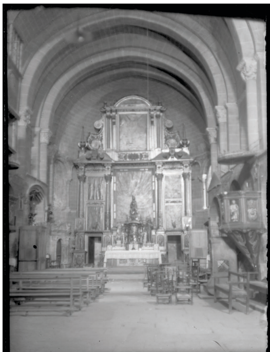
▪ Fig. 4. Iglesia de Santa María, Uncastillo, vista interior del templo antes de la restauración de los años 60. Fuente: Fundación Uncastillo.
