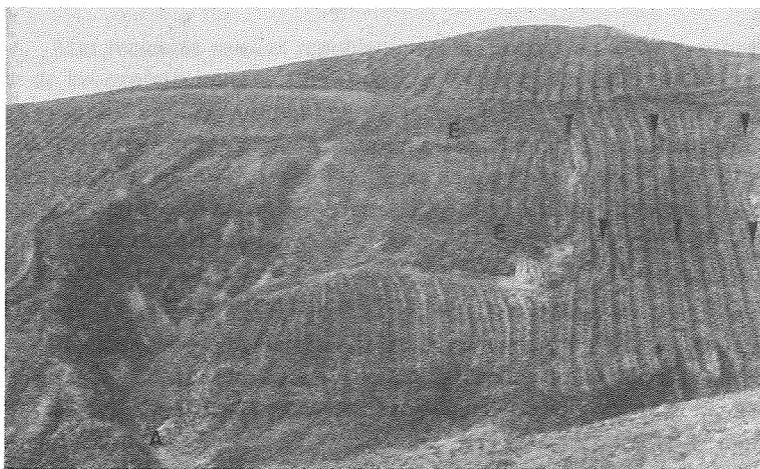
Foto nº 2. Corta principal (C) de las explotaciones del río de la Sierra. Sobre la cortan se ubican los depósitos de explotación (E) a los que el agua llegaba por canales indicados por las flechas. En la montera de la mina se observan varias zanjas-canal que parten del canal superior. Los hoyos han transformado bastante el conjunto, sólo la corta y el canal de lavado (A) permanecen intactos.
