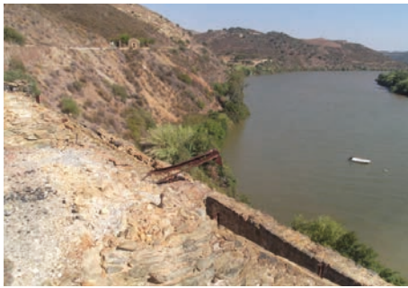
Antiguo embarcadero minero del Puerto de La Laja (El Granado). El Guadiana en su tramo navegable se usó para transportar el mineral de la faja pirítica a los mercados europeos. Foto de J.M. Jurado, 2010.
