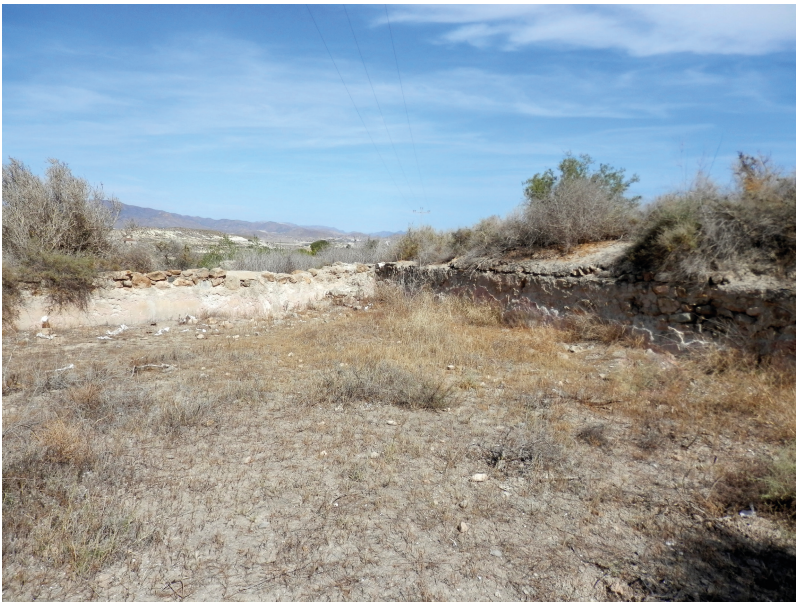
Imagen 4: Balsa que acumulaba las aguas captadas por el minado, la presa y la aceña/pozo
