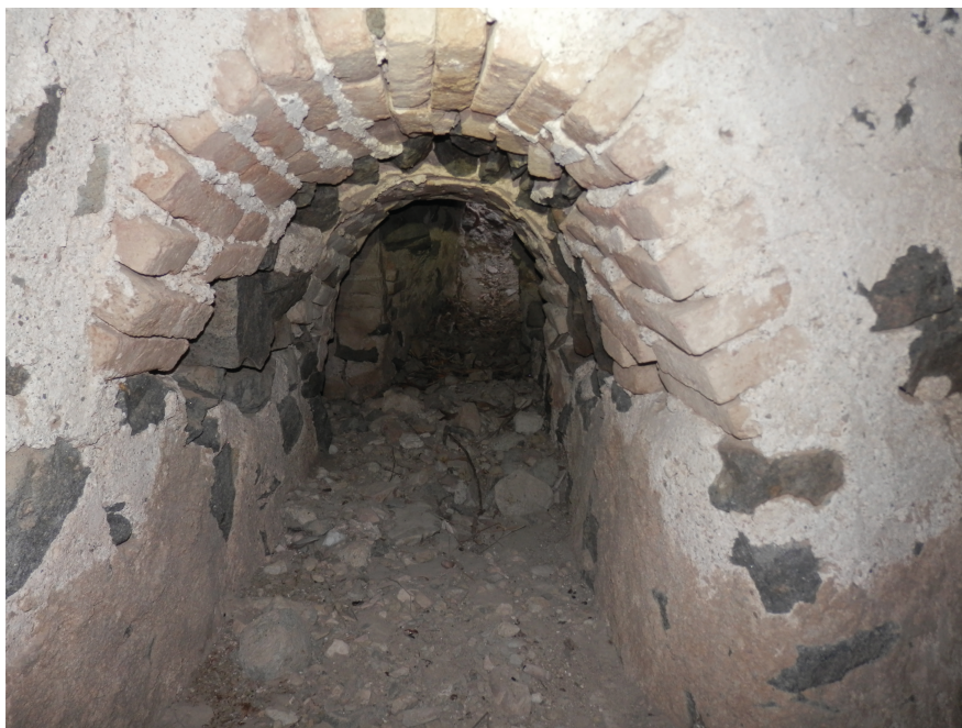
Imagen 1: Galería de captación, segmento abovedado mediante ladrillo próximo a la rambla
