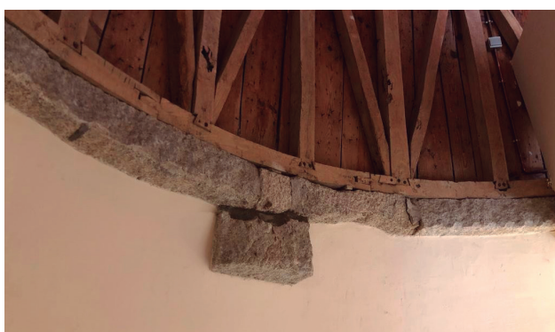
Figura 6. Antonio Gaudí: palacio episcopal de Astorga: anillo de piedra del arranque del chapitel del torreón norte (h. 1893). (Fotografía del autor del artículo).
