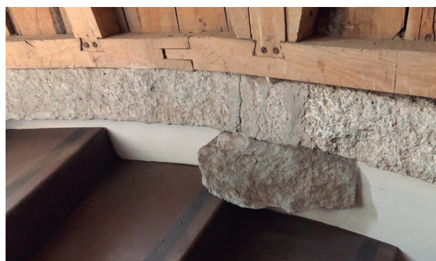
Figura 5. Antonio Gaudí: palacio episcopal de Astorga: anillo de piedra del arranque del chapitel del torreón norte (h. 1893). (Fotografía del autor del artículo).
