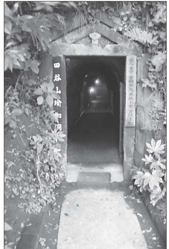
ENTRADA A LA CUEVA TAYA, EXCAVADA A MANO CON ARCILLA ENDURECIDA (COMPLEJO DEL TEMPLO DE JOSEN, JAPÓN).
