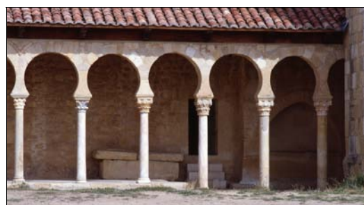
■ Lám. 16. San Miguel de Escalada. Ampliación del pórtico meridional.
