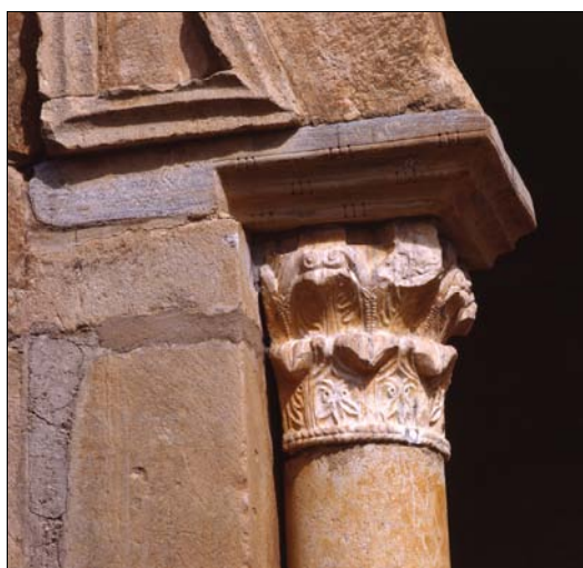
■ Lám. 29. San Miguel de Escalada. Primer capitel del pórtico meridional).
