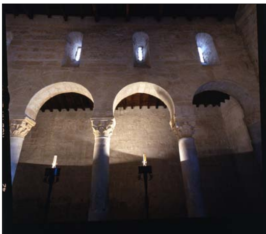
■ Lám. 1. San Juan de Baños. Intercolumnio de la nave central.
