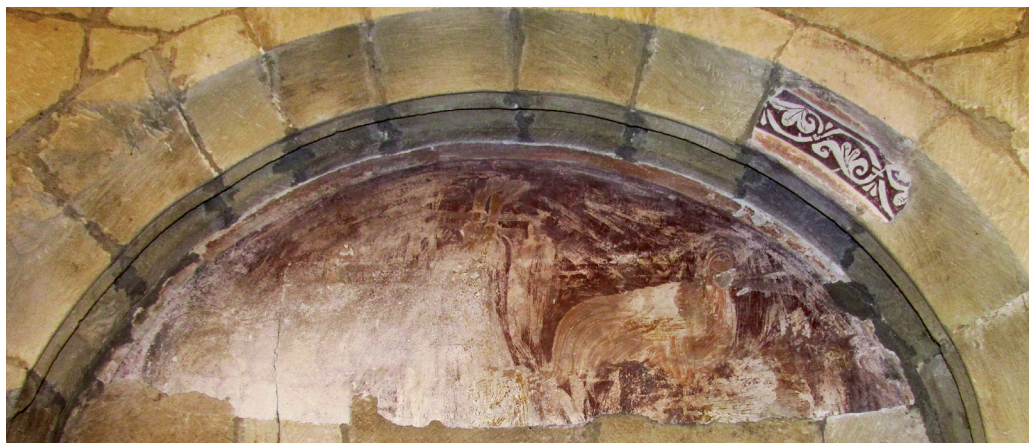
▪ Fig.8. Arco segundo antes de su restauración
