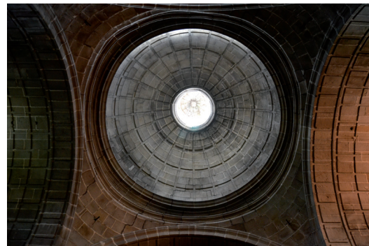
▪ Fig.10. Bóvedas y media naranja de la iglesia del convento de Vista Alegre. (Foto del autor).
