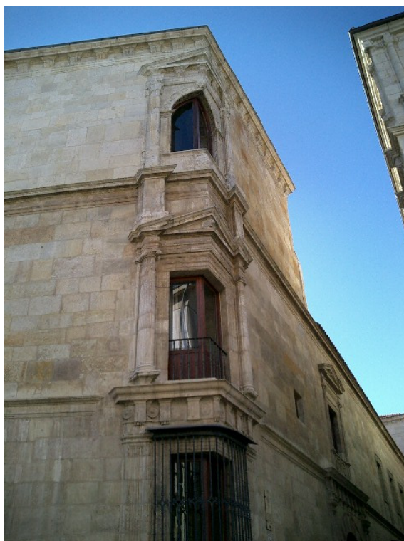
■ Lám. 2. Vanos en ángulo del palacio de los Guzmanes
