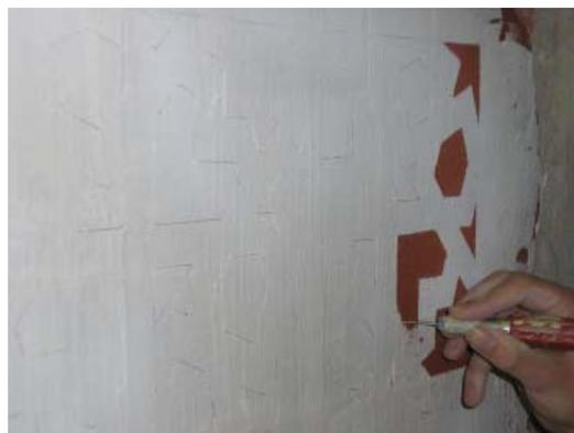
▪ Fig. 2. Proceso de esgrafiado en la variante técnica del “acabado en cal”. Foto: Mari Mar Nevado.
