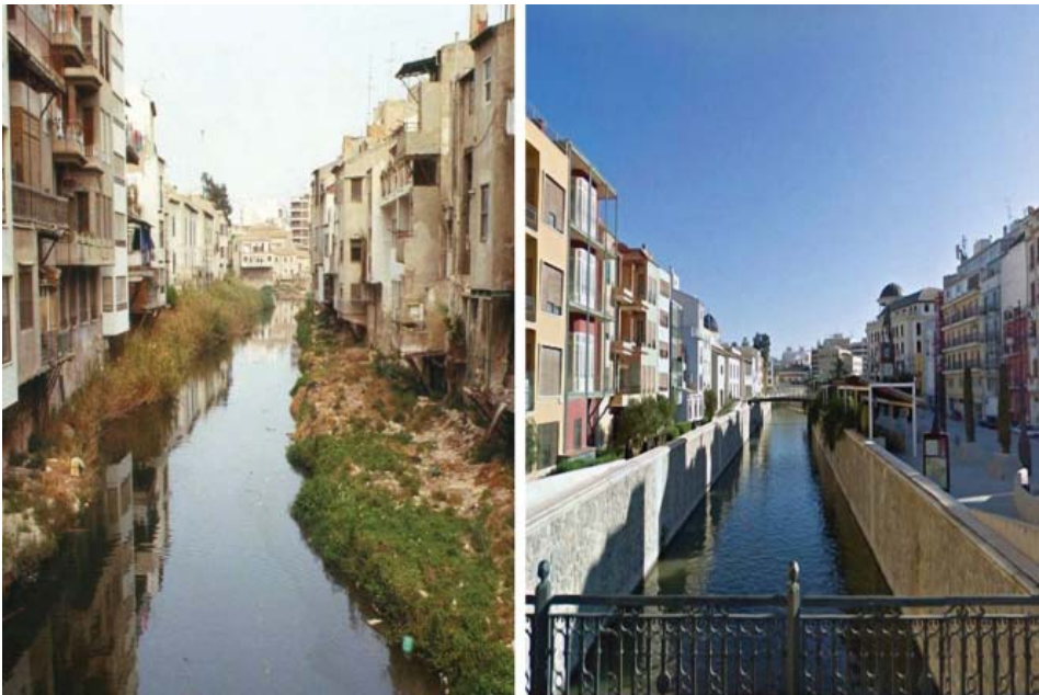
Figura 8. Orihuela. Fotografías del cauce del río Segura a su paso por el casco urbano desde el puente Viejo. Comparativa imagen 1985 y 2005 (tras las intervenciones de remodelación del cauce)
